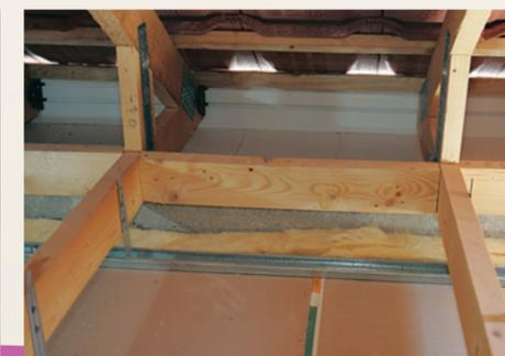
L'étréssillon de charpente bloque la laine soufflée sur l'isolant vertical pour éviter le pont thermique et vient empêcher le contact du vent avec l'isolant.
