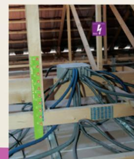
Boîtier électrique fixé hors du volume de l'isolant.
