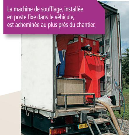
La machine de soufflage, installée en poste fixe dans le véhicule, est acheminée au plus près du chantier.
