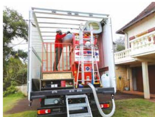
La machine de soufflage, installée en poste fixe dans le véhicule, est acheminée au plus près du chantier.
