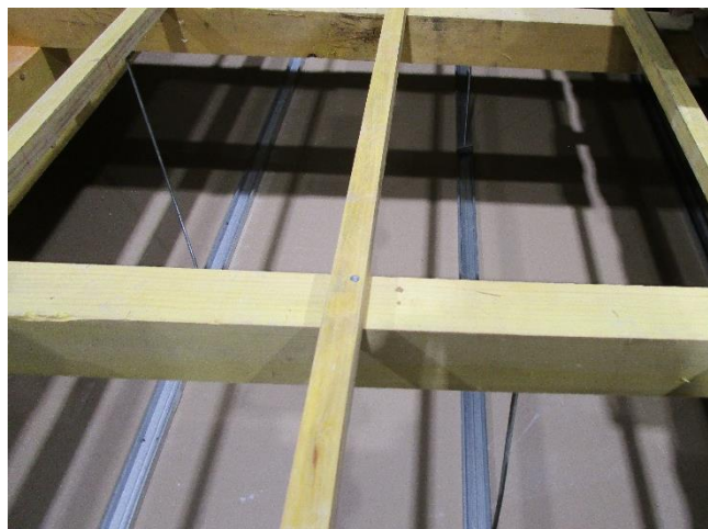
Charpente avec plafond (vue du dessus)
