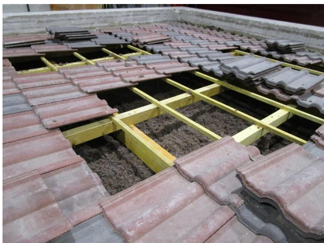
Soufflage de l'isolant terminé
