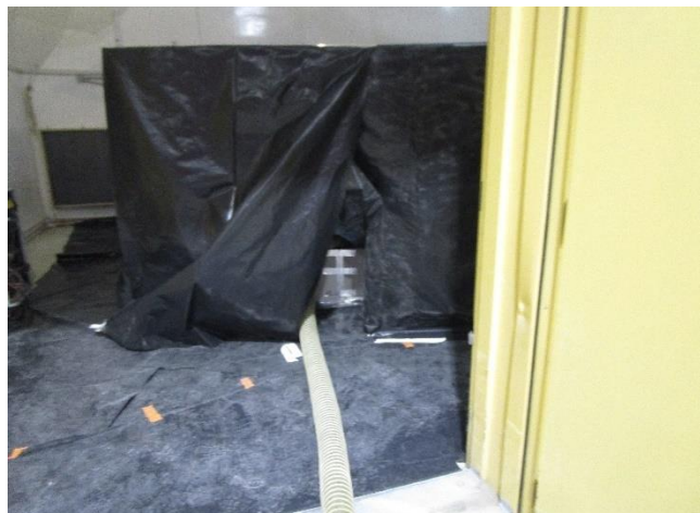
Soufflage de l'isolant
