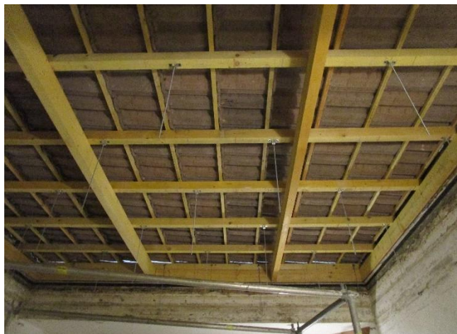
Charpente terminée avec suspentes
