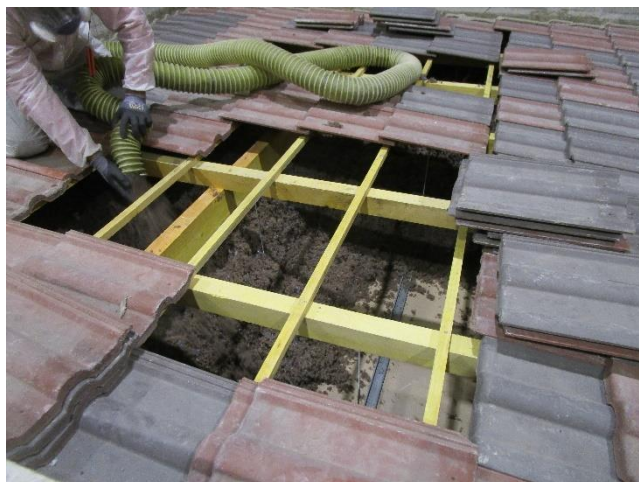
Toiture détuilée pour soufflage de l'isolant
