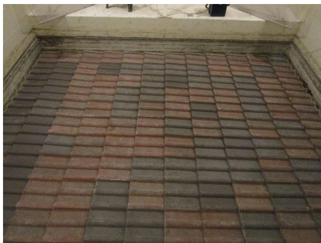
Toiture (vue dans le poste d'essais)
